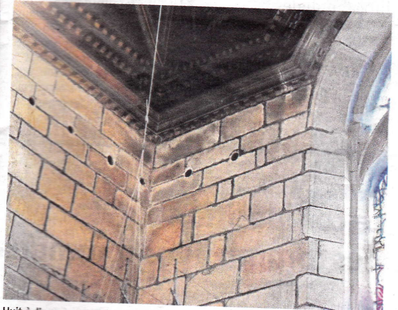
Huit à dix vases acoustiques de ce genre vont être débouchés au niveau du chœur.
